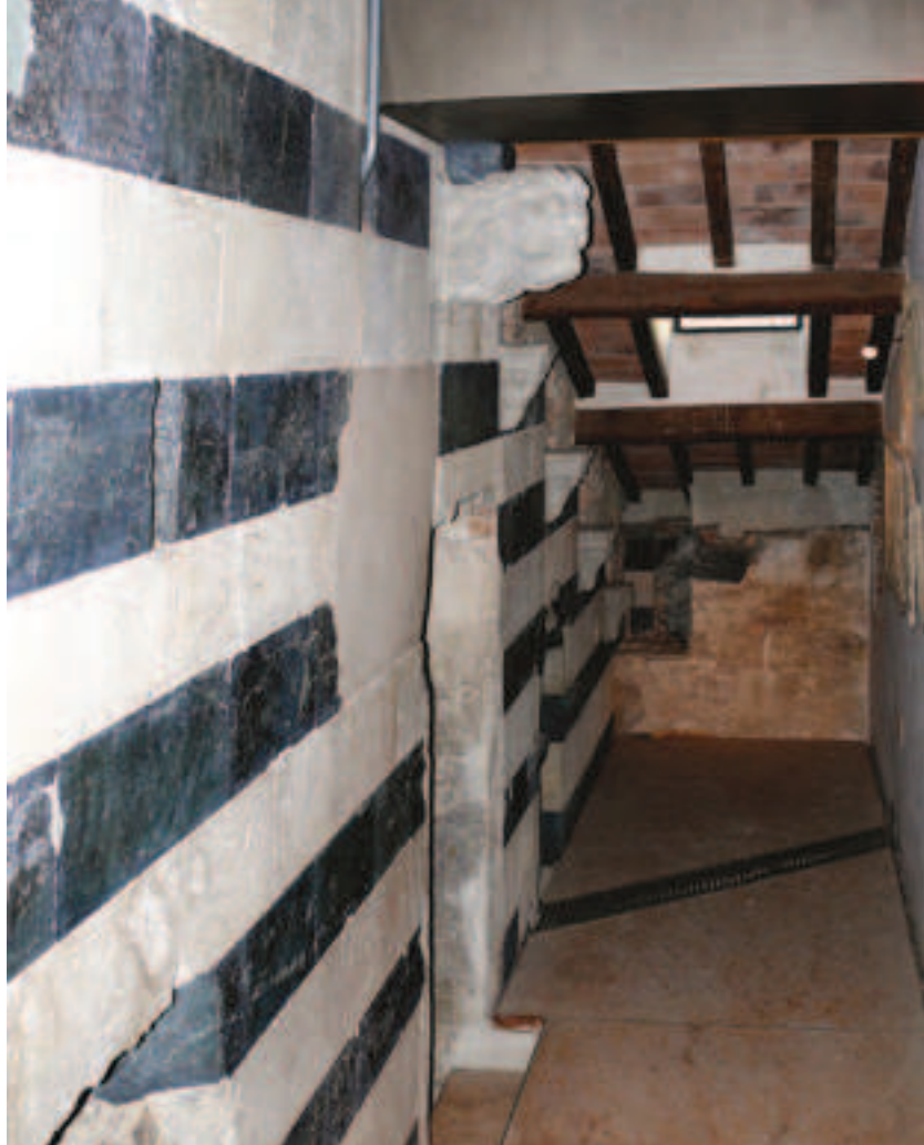
Duomo di Prato, corridoio interno della facciata
