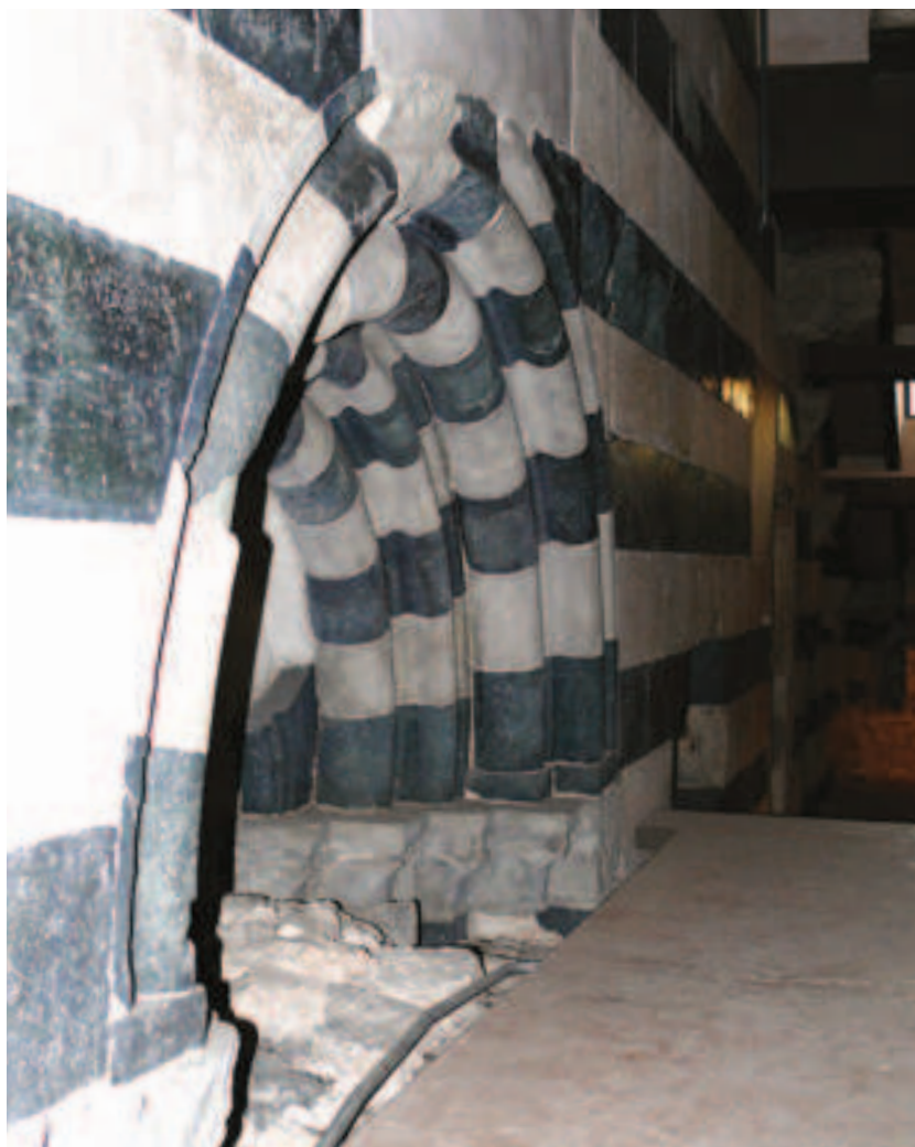
Duomo di Prato, corridoio interno della facciata
