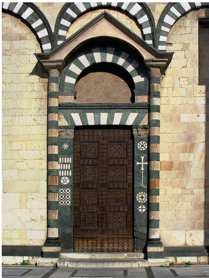
Fig. 1 Il portale del Duomo sul lato sud in prossimità del campanile.
